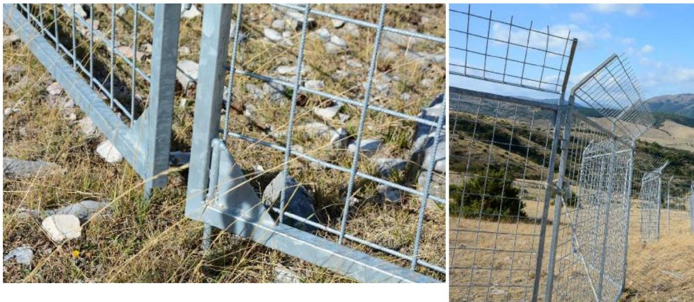
fig.4 - Esempio tipologia di recinzione mobile oggetto dell'appalto
