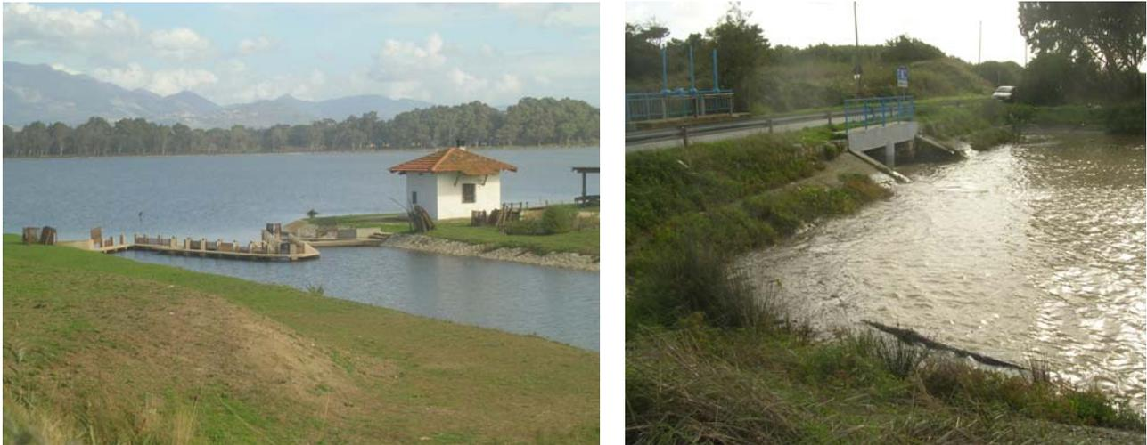
Figura 1 – Imbocco della Foce Nuova di Fogliano (a sinistra) e sbocco a mare (ovvero nel tratto terminale del rio Martino) della Foce di Monaci, regolata da paratoie (a destra).
